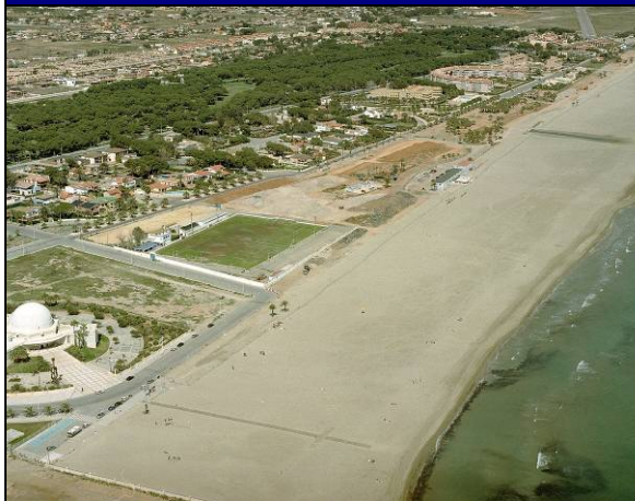
Foto Aérea: Previo a la Obra
