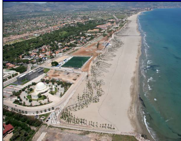
Foto Aérea: Final de Obra
