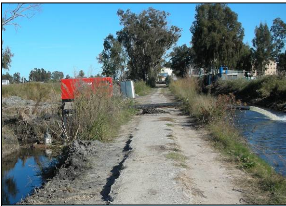
Equipo de bombeo drenando las parcelas.
