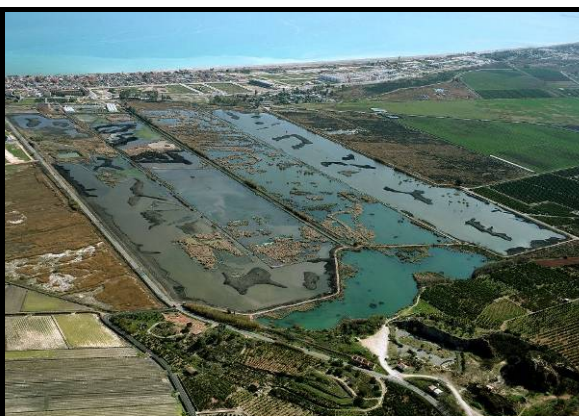
Vista Aérea tras finalizar los movimientos de tierras
