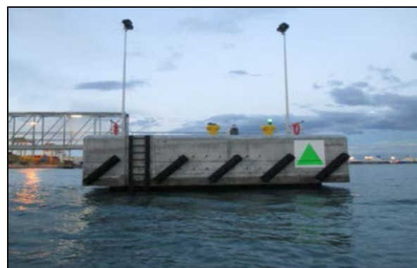
Instalación de bolardos y defensas
