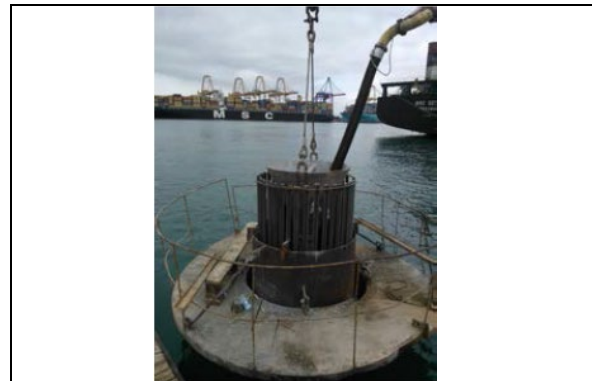
Hormigonado pilotes
