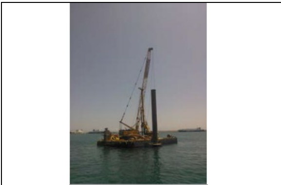
Hincado camisa perdida de pilotes
