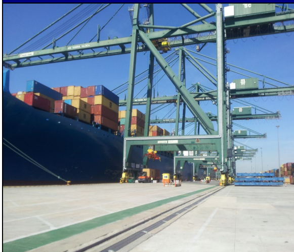
Muelle MSC Previo a la Obra
