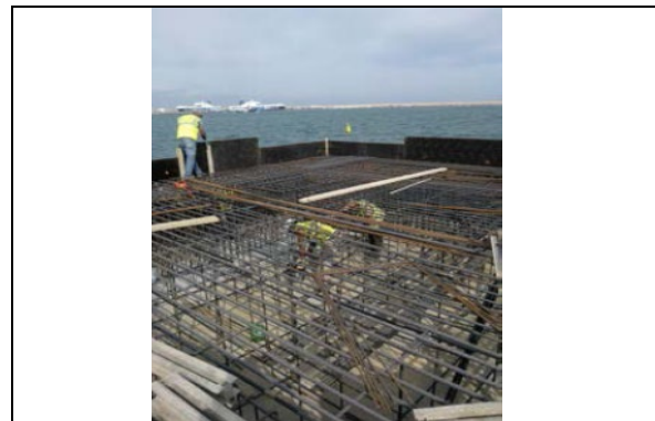
Colección de la armadura del encepado
