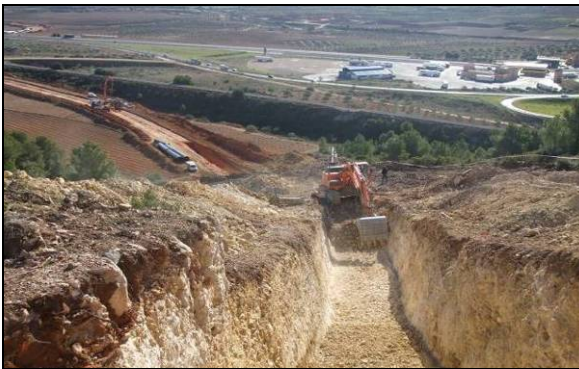
Excavación zanja en subida al Ramblar
