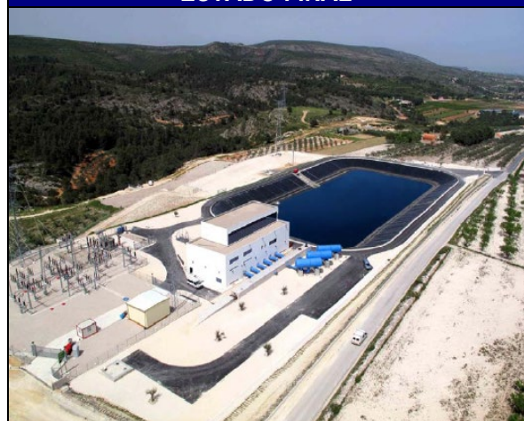
Foto Aérea: Final de Obra
